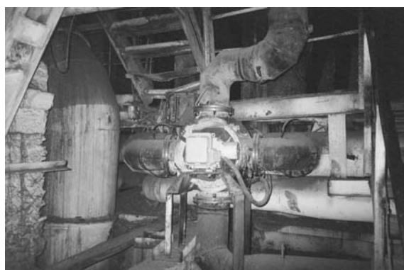
Рис. 3. Перекидной дымовоздушный клапан ДВК
